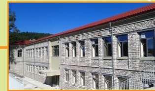
Αποκατάσταση στατικής επάρκειας του γυμνασίου Θέρμου
