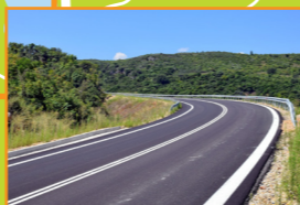
Ανακατασκευή δρόμου Κουβαρά - Φυτείες - Αστακός
