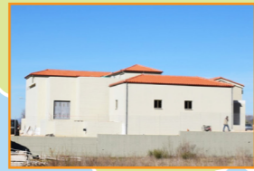
Εγκαταστάσεις επεξεργασίας λυμάτων Μενιδίου
