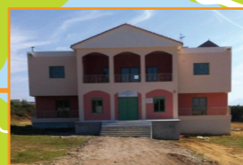
Ανέγερση στέγης υποστηριζόμενης διαβίωσης (ΣΥΔ) - Οικοτροφείου του εργαστηρίου «Παναγία Ελεούσα» στο Αργίνο
