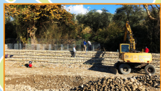
Αποκατάσταση αντιπλημμυρικών τεχνικών έργων Π.Ε. Αιτωλοακαρνανία
