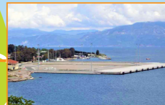
Ολοκλήρωση Λιμενικών Έργων και Κατασκευή Βασικών Έργων Επιδομής Νέου Λιμένα Αιγίου
