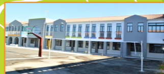
Κατασκευή Λυκείου Δεμενίκων
