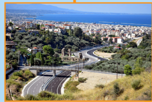
Κατασκευή Μικρής Περιμετρικής Πατρών
