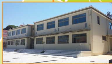
Ανέγερση Δημοτικού Σχολείου Λάππα
