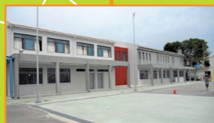
Ολοκλήρωση Ανέγερσης Γυμνασίου Κάτω Αχαΐας
