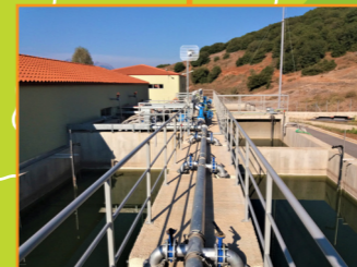
Κατασκευή Βιολογικού Καθαρισμού Καλαβρύτων
